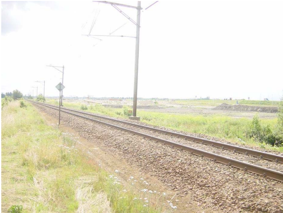
Spoorlijn Utrecht - Leiden met aan rechterzijde plangebied OTA
